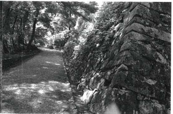
復元天守石垣（下の約 1/3 は 明智時代の穴太積み・現状図⑤）
